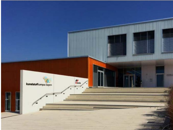
Blick auf den kunststoffcampus bayern: ab dem 01. Oktober wird hier die k3 works GmbH einen weiteren Standort eröffnen (Quelle: k3 works GmbH)
